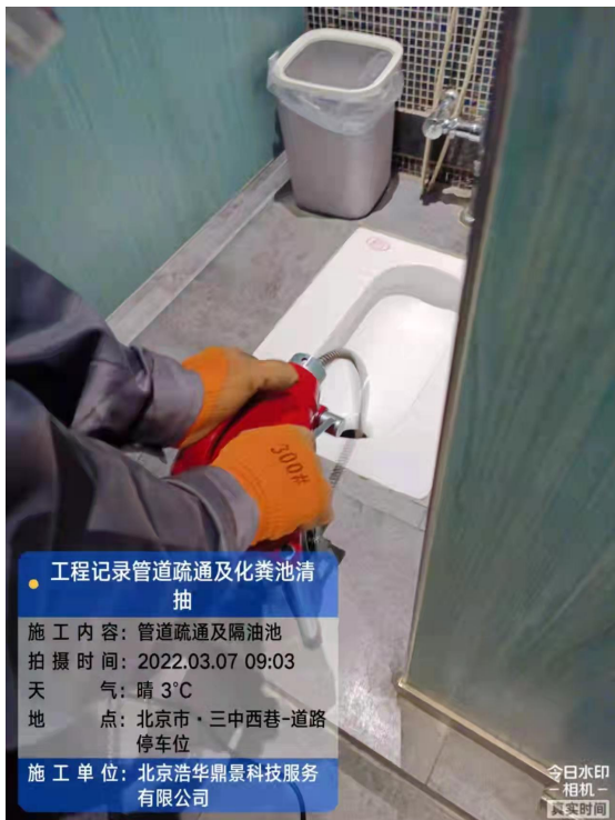
● 工程记录管道疏通及化粪池清抽 施工内容: 管道疏通及隔油池 拍摄时间: 2022.03.07 09:03 天气: 晴 3°C 地点: 北京市·三中西巷-道路停车位 施工单位: 北京浩华鼎盛科技服务有限公司
