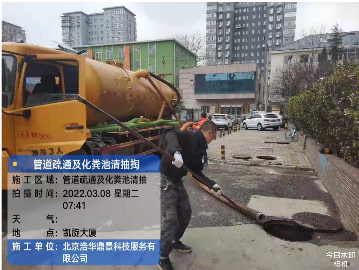
● 管道疏通及化粪池清抽掏 施工区域：管道疏通及化粪池清抽 拍摄时间：2022.03.08 星期二 07:41 天气： 地点：京门老爆三林肯公园店 施工单位：北京浩华鼎景科技服务有限公司
